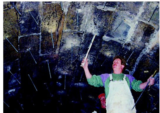
Eisenbahnüberführung Strecke Dresden – Werdau
