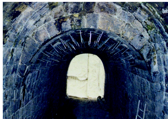
Eisenbahnüberführung Strecke Dresden – Werdau
