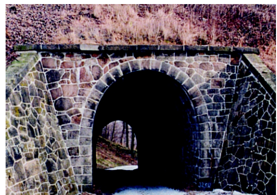
Eisenbahnüberführung Strecke Dresden – Werdau
