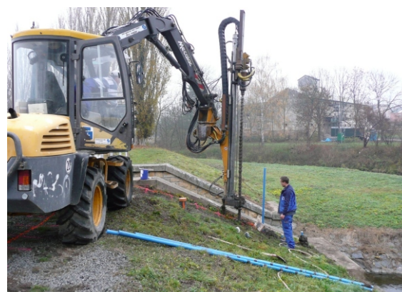
Abteufen der Bohrungen für die Manschettenrohre
