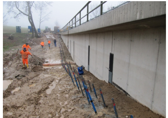
Anordnung der Manschettenrohre
