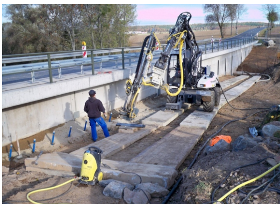
Abteufen der Bohrungen
