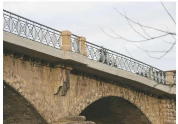
Erneuerte Kappen und Fahrbahnplatte
