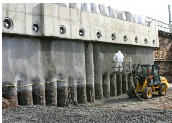
Bohrpfahlwand mit Spritzbeton und Kopfbalken
