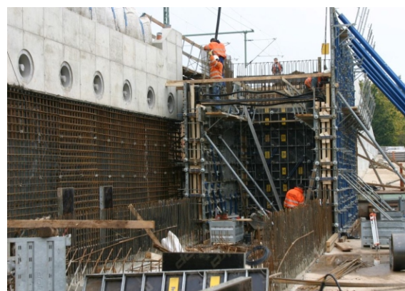
Treppenanlage mit Technikraum zum Bahnsteig 1
