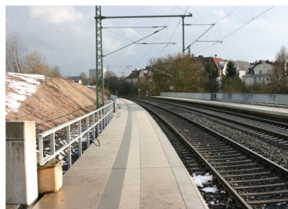
Fertiggestellter Haltepunkt Kirchditmold
