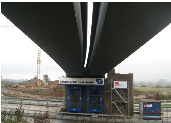
BW 7 - Brücke über die A 661, Stahlteile
