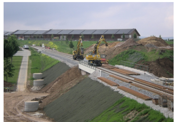
BW 6 - Brücke über einen Feldweg
