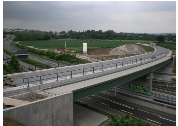
BW 7 - Brücke über die A 661
