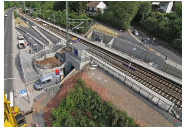
Fertiggestellter Haltepunkt Bartenwetter Brücke
