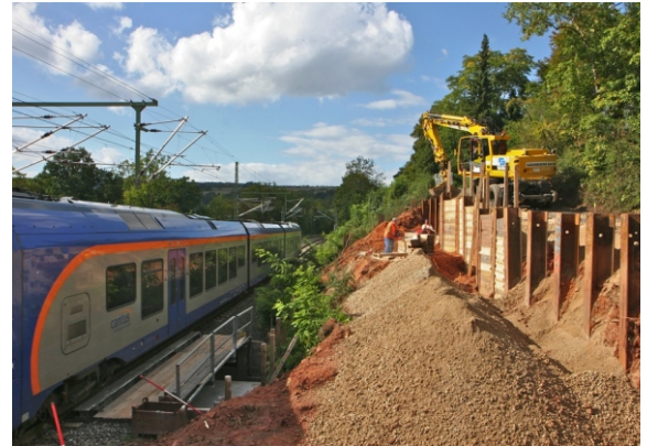
Verbauarbeiten Bahnsteig 2
