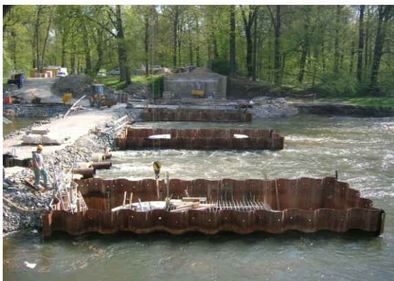
Errichtung der Pfeiler in Spundwandkästen
