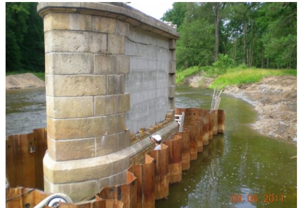
Pfeiler mit Natursteinverkleidung
