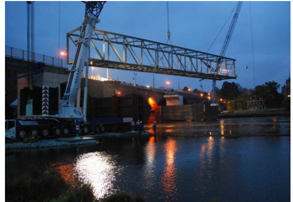
Einhub des Fachwerküberbaus
