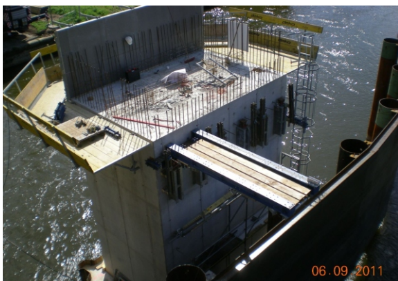
Pfeiler ... mit Tragwerk
