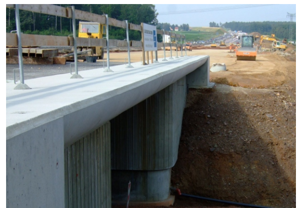
BW 95 - Ersatzneubau Autobahnbrücke
