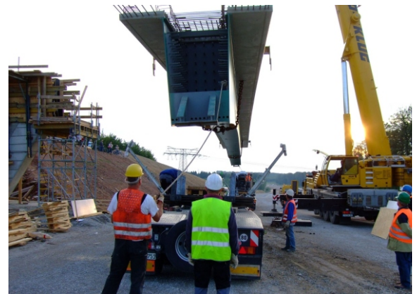
BW 99Ü1 - Einhub des Verbundfertigteil-Trägers
