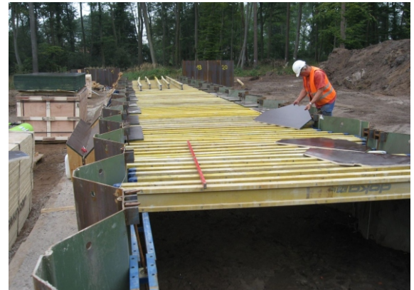
Schalung und Traggerüst Überbau
