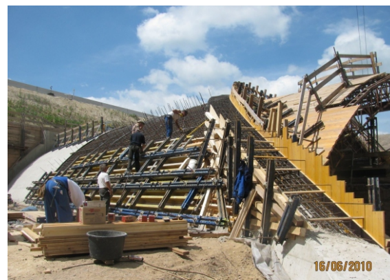
Errichtung der Schalung, 2. Bauabschnitt
