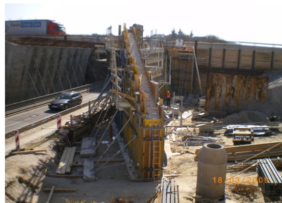
BW 127 mit geneigten Widerlagern
