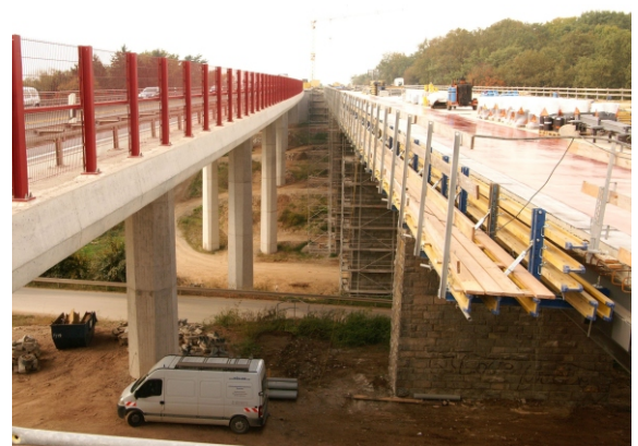
Kappenschalung Sprottetalbrücke
