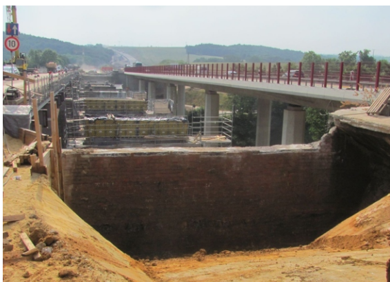
Herstellen der Auflagerbänke, 2. Bauabschnitt
