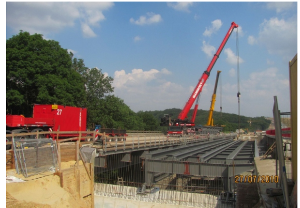
Stahlträgerrost, 2. Bauabschnitt
