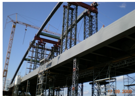
Fertigung der Brückenbögen
