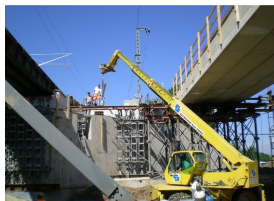
Arbeiten unter der Hilfsbrücke
