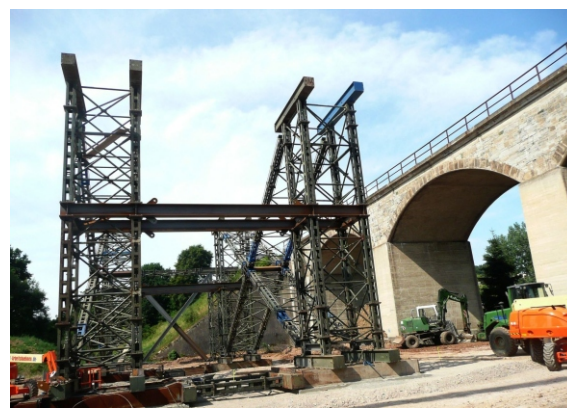
Gerüst für die Vormontage des Stahlüberbaus
