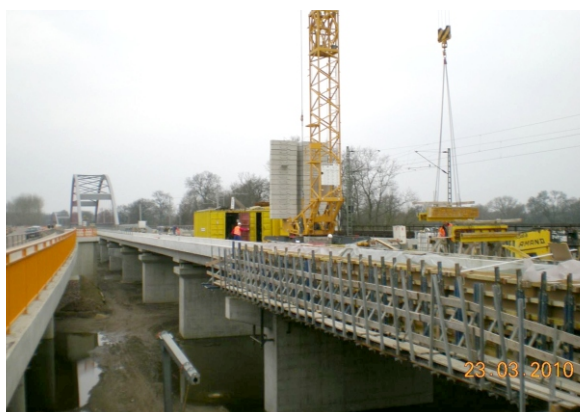
Abschnittsweise Fertigstellung der Muldeflutbrücke
