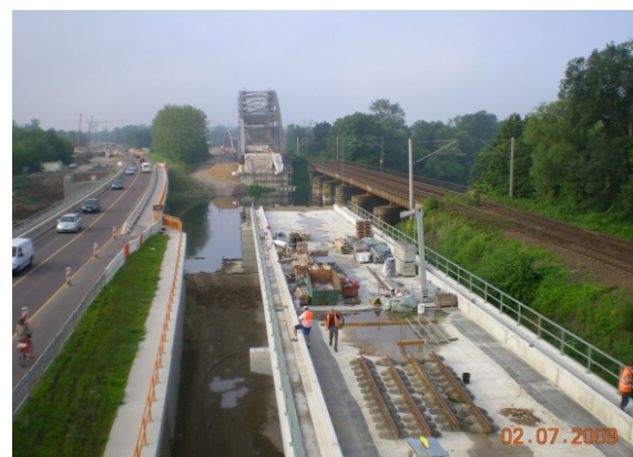
Muldeflutbrücke (mit Muldebrücke vor Verschiebung)
