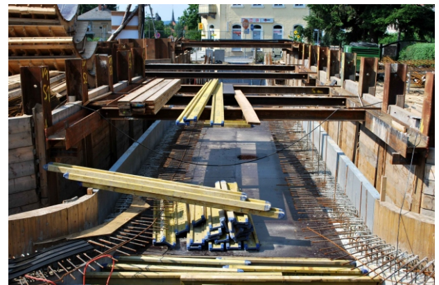
BW 16, Personentunnel Sachsenstraße
