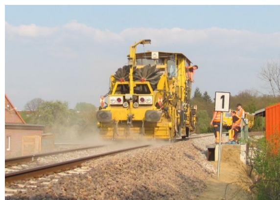
Einsatz der Stoppmaschine
