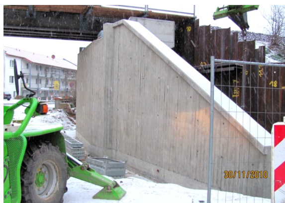
Widerlager Achse 20 mit Hilfsbrücke
