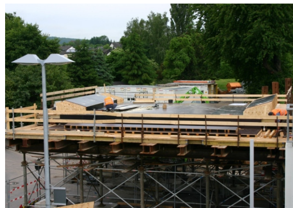
Errichtung des Überbaus auf der Verschubbahn
