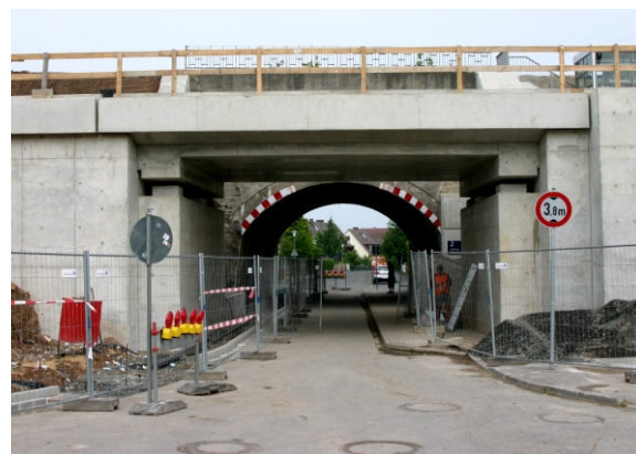
Überbau nach Einschub
