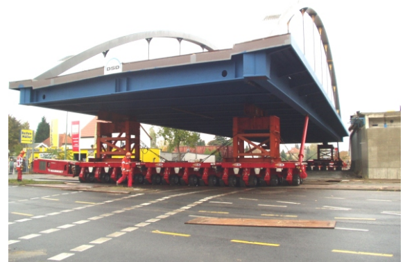
Einfahren des Brückenüberbaus
