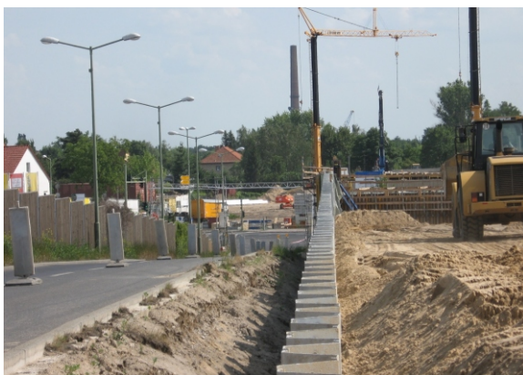
Baustellenbereich und befahrene Rampe
