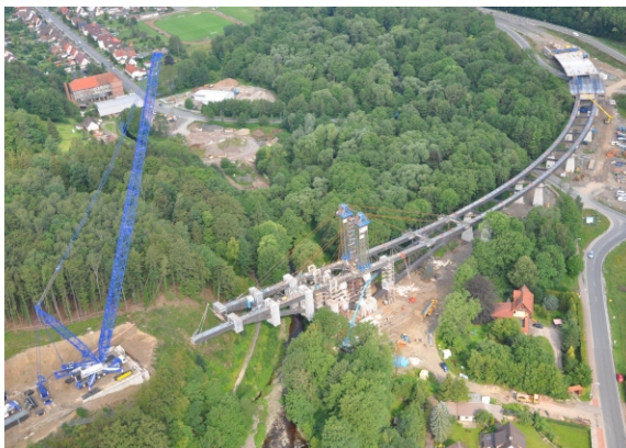
Montage der Bogenkonstruktion mittels Hilfspylon
