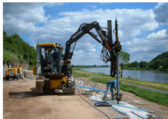
Einbau von Kleinverpresspfählen
