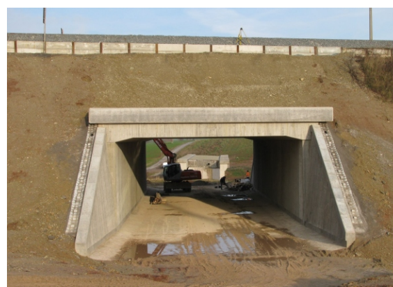
Fertiggestellte Eisenbahnüberführung Niederorschel
