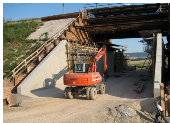
EÜ im Bau
