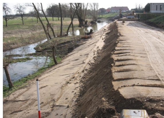
Ertüchtigter Deichkörper vor Auftrag des Oberbodens
