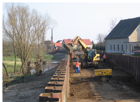
Auffüllen des Deichkörpers zwischen den Spundwänden
