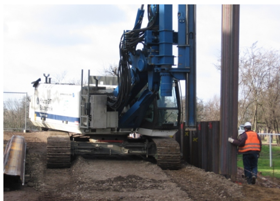
Einrütteln oder -vibrieren der Spundbohlen
