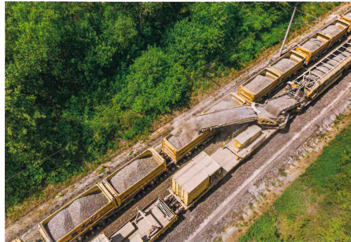
Bild 3: Umbunkern ins Nachbargleis
