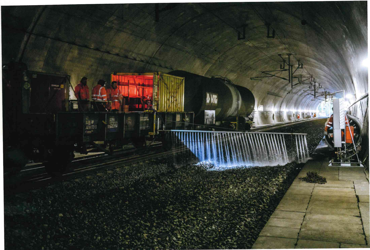
Bild 8: Schotterbenetzung vor Ausbau des Altschotters
